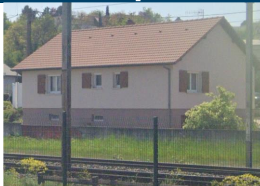
Façade Nord-Ouest / Nord-Est
