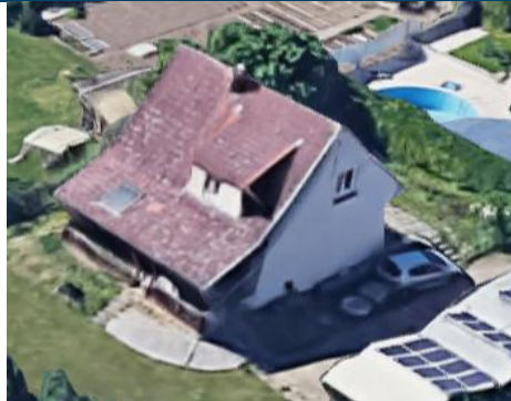
Façade Nord-Est / Nord-Ouest
