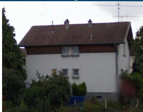
Façade Nord-Est / Nord-Ouest
