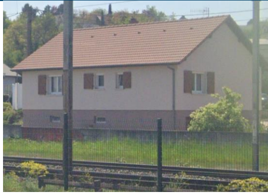
Façade Nord-Ouest / Nord-Est
