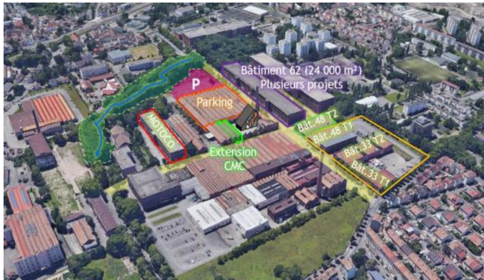
Photo n° 1 : Vue d'ensemble du site et les zones en projet et déjà réhabilitées fin 2023
