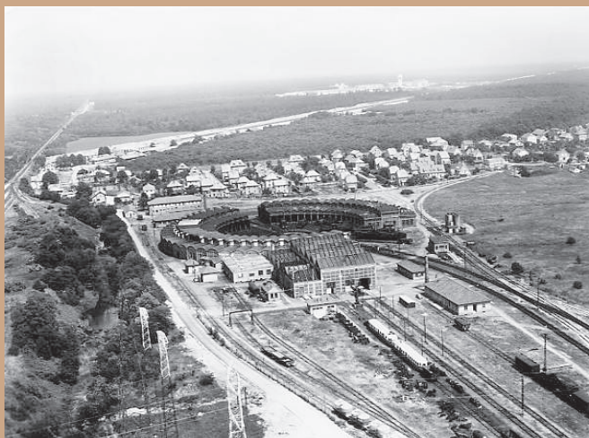
Le dépôt de chemin de fer avec sa rotonde et la cité des cheminots et au fond le canal de Huningue.
