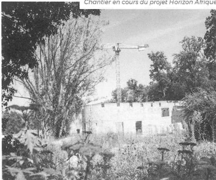
Chantier en cours du projet Horizon Afrique
