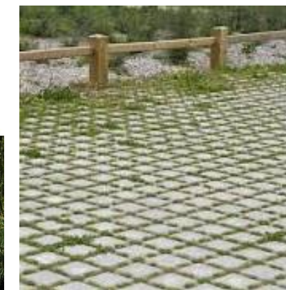
Stationnement en pavés drainants pour lutter contre l'imperméabilisation des sols
