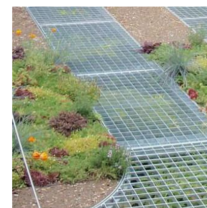
Cheminements alternatifs en caillebotis métallique
