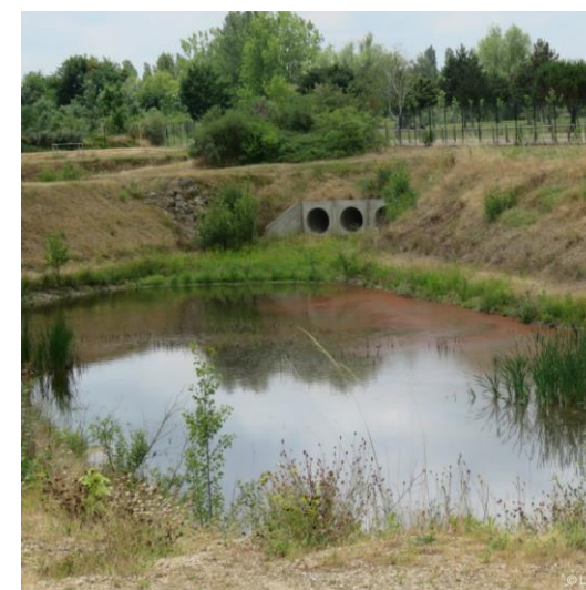
+ Bassin de rétention
