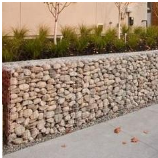
Gabions de galets du Rhin
